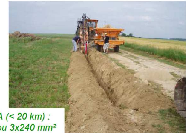
Enfouissement câbles : 0,5 à 1 m de profondeur
